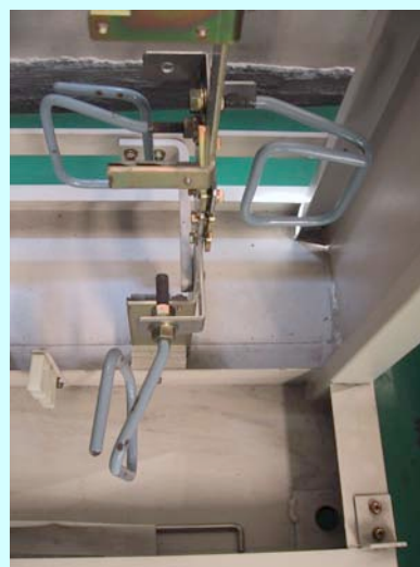
AMDF-ジャンパリングアダプタ (19号配線輪をバーチカルバーに取付)
