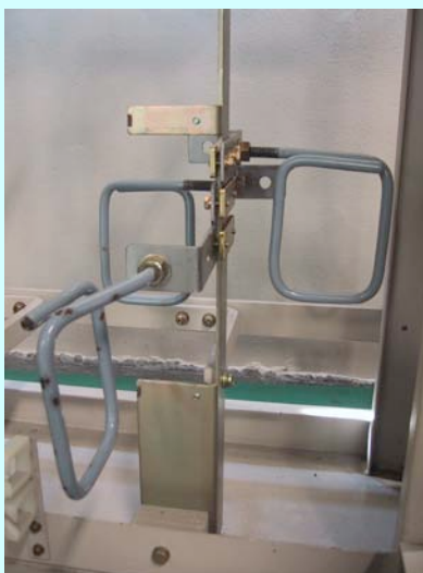
AMDF-ジャンパリングアダプタ (19号配線輪をバーチカルバーに取付)
