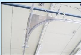
直線/曲線/分岐レール、これらのレールを組み合わせることで、室内を自由に見て回ることができます
